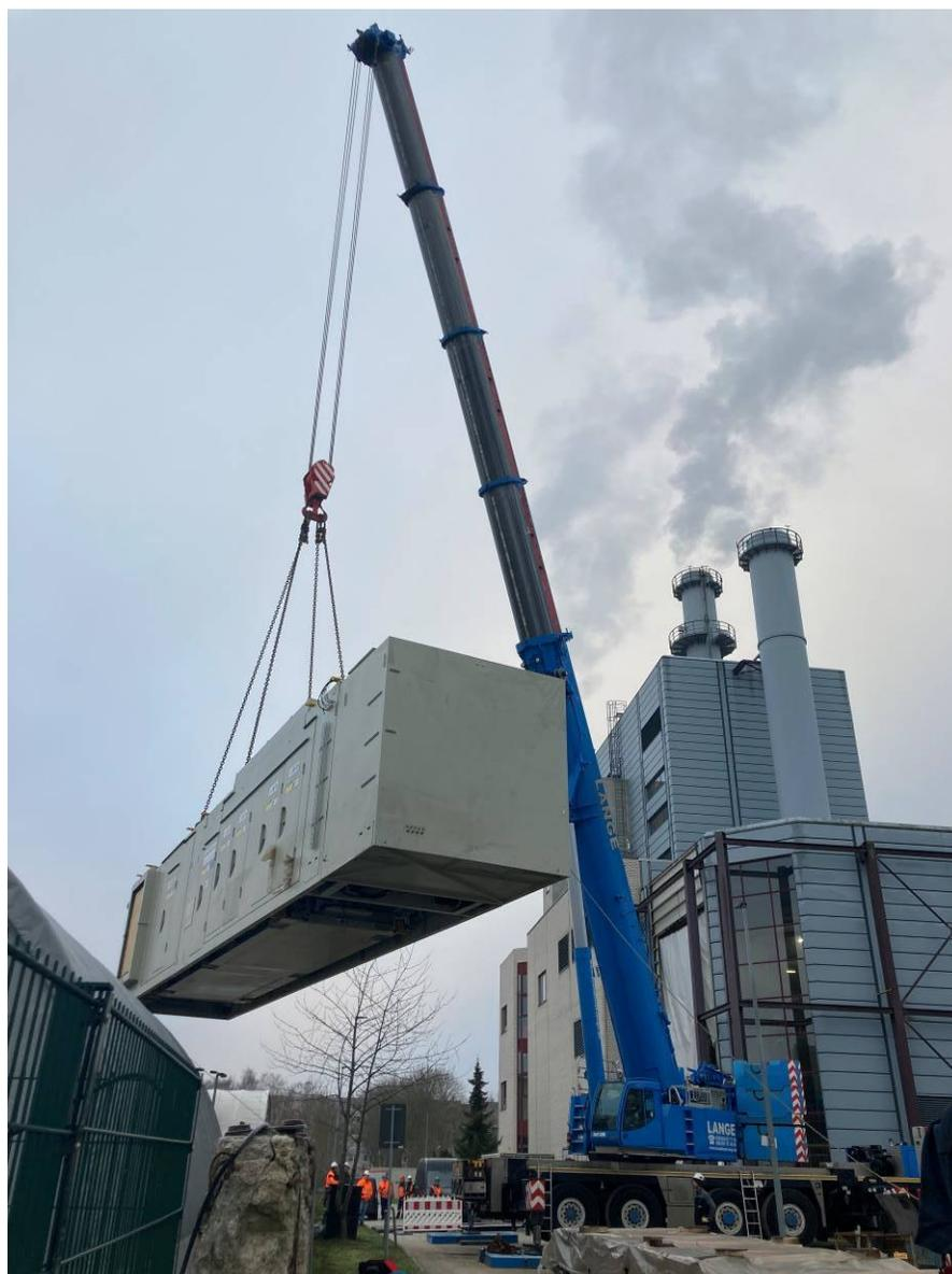
BU: Der 400 Tonnen Autokran hebt die 50 Tonnen schwere Gasturbine vom Schwerlasttransporter und muss sie zur Einbringung in die Kraftwerkshalle noch um 90 Grad drehen.
