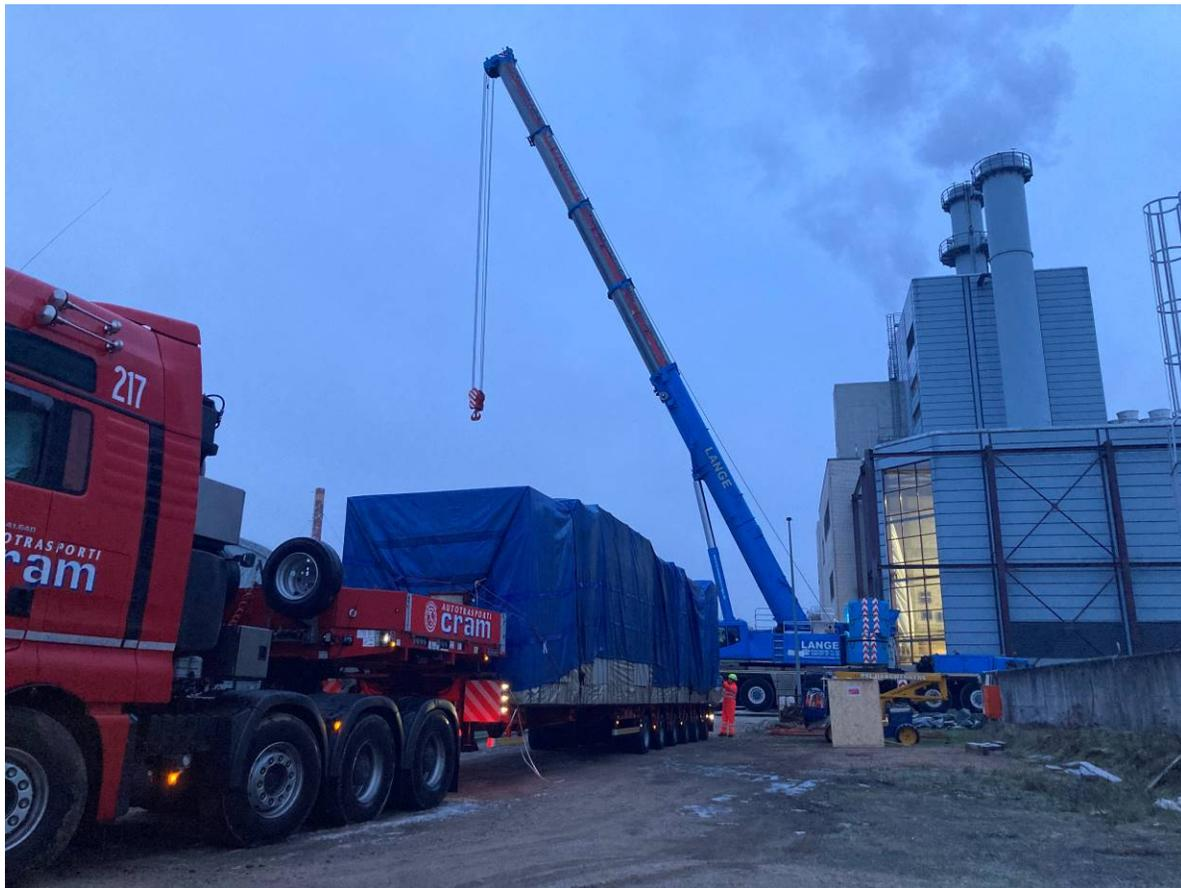
BU: Mit einsetzendem Tageslicht beginnt die Verladung der in einem Container verbauten Gasturbine.
