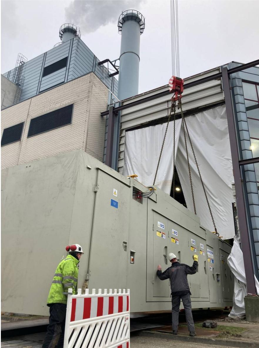
BU: Langsam lässt der 400 Tonnen Autokran die 50 Tonnen schwere Gasturbine am Eingang zur Kraftwerkshalle auf vier Schwerlastrollen ab. Auf diesen wird sie dann durch einen speziellen Seilzug hineingezogen.
