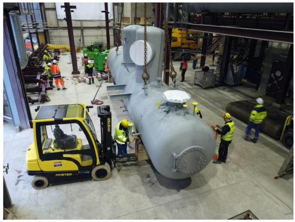
BU: Der kraftwerkseigene Kran hebt den 27 Tonnen schweren Kondensator an, damit er langsam auf den Schwerlastrollen abgesetzt werden kann.
