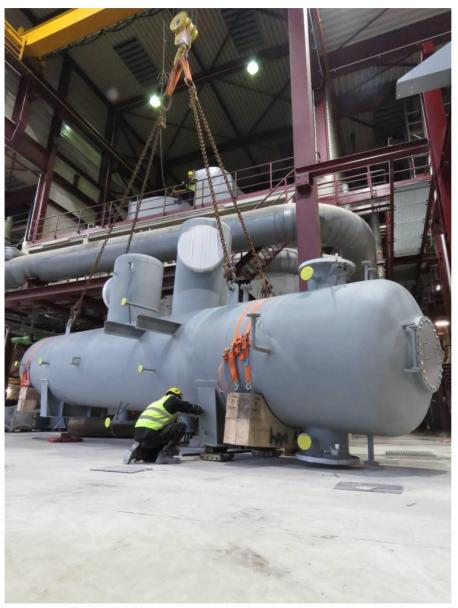
BU: Mit Hilfe des kraftwerkseigenen Krans wird der 27 Tonnen schwere Kondensator für den Transport zu seinem Bestimmungsort im Gebäude auf Schwerlastrollen abgesetzt.
