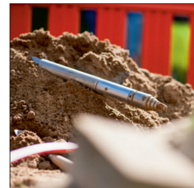
Per Erdrakete werden die Leerrohre unter die Erde gebracht
